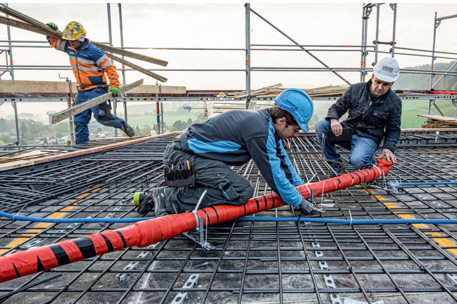
Pascal Grossenbacher, Chefmonteur Gehatec, und Adis Basic von Urfer-Müpro prüfen die Einlegearbeiten
