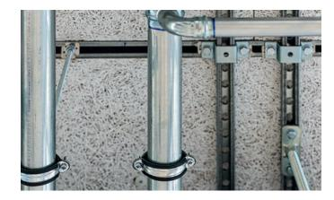
Raster Montageschienen eingebaut, sie dienen als Grundgerüst über der ganzen Anlage. Dies ermöglicht ein flexibles Andocken aller weiteren Bestandteile und lässt auch für künftige Anpassungen und Erweiterungen alle Möglichkeiten offen. Urfer-Müpro war von Beginn weg involviert und hat auch bei der Planung der Gesamtanlage tatkräftig mitgeholfen. Zusammen mit den Schienen sind auch Gewindestangen, Rohrschellen und das passende Zubehörsortiment im Einsatz.
