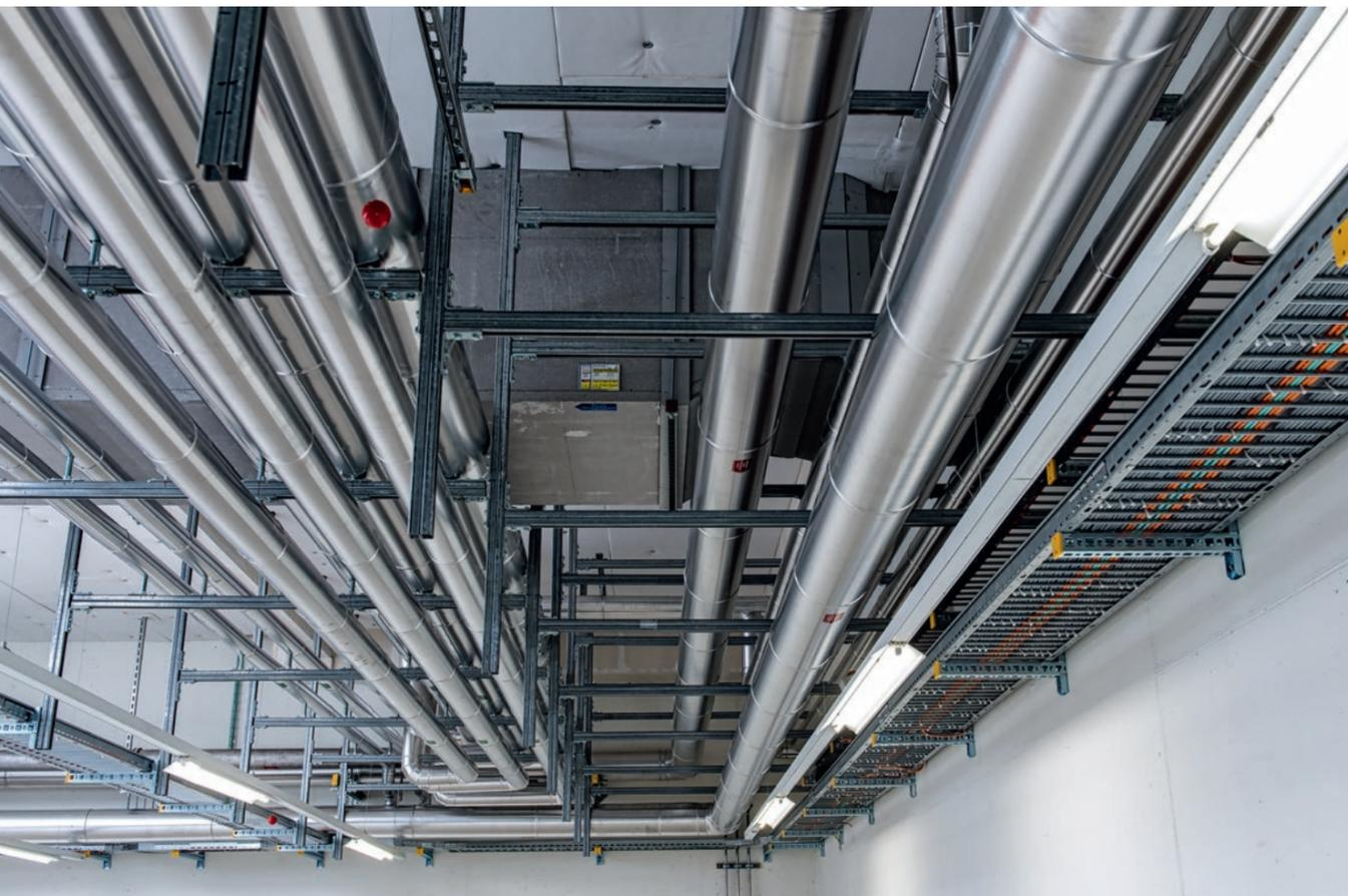
Detailansicht der dreistufigen Schienenkonstruktionen/
