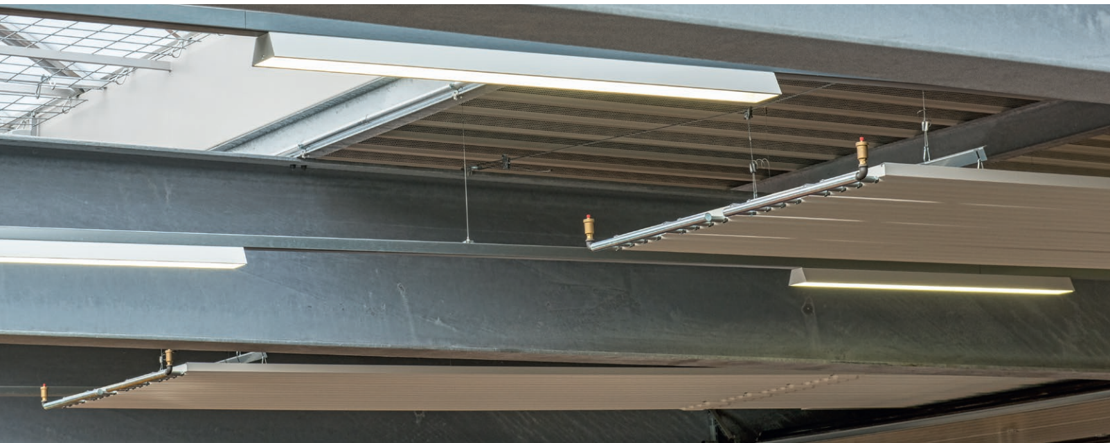
Filigrane Montagetechnik direkt unter dem Hallendach
