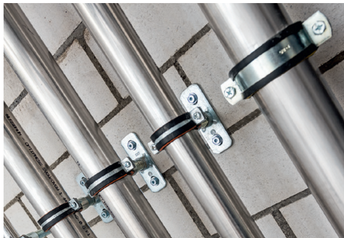
Rohre in Reih und Glied gehalten von Urfer-Müpro-Rohrschellen.
