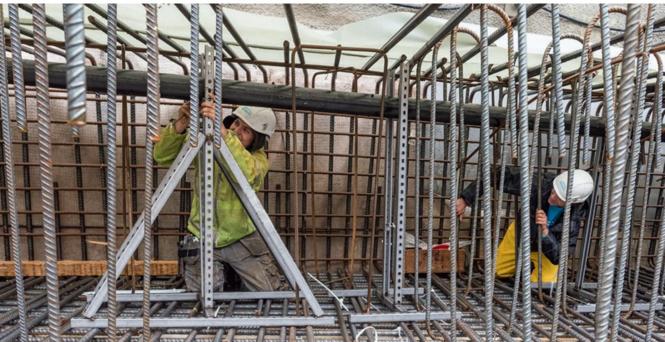
Zwei Engie-Mitarbeiter beim Einsetzen der Urfer-Müpro Spezialkonstruktionen.
