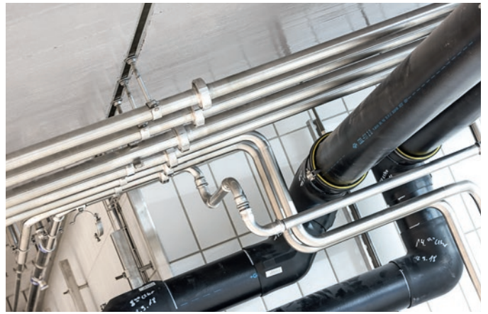
Leitungstrasse mit Distanzhaltern fixiert.
