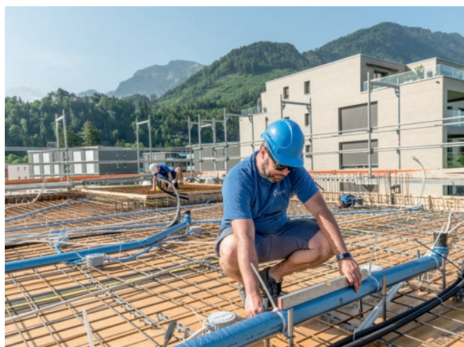
M. Pohle kontrolliert das Gefälle des Abflussrohres.
