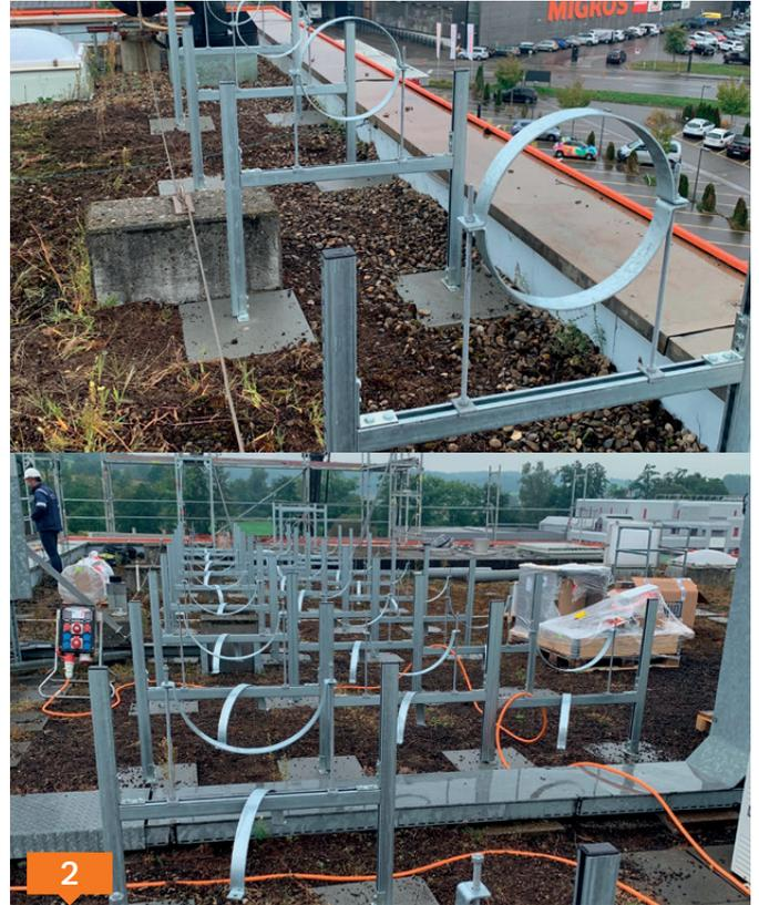
Eine der speziellen Herausforderung bei diesem Objekt war es, die Befestigung auf dem Dach für die herrschenden Schnee- und Windlasten zu dimensionieren und dabei die Vorgabe der maximalen Dachlast einzuhalten.
