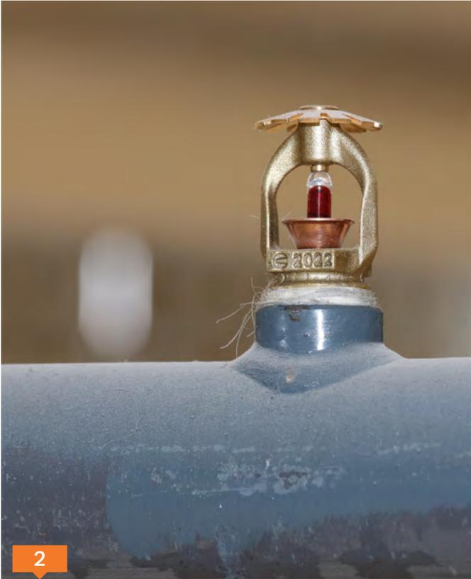
Detailansicht einer fertig montierten Sprinkleranlage.
